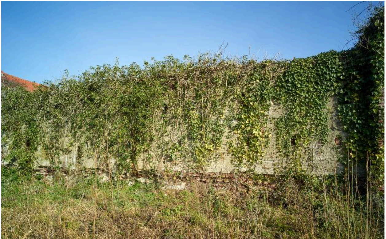
Elévation ouest de la ferme, créneaux de fusillade.
