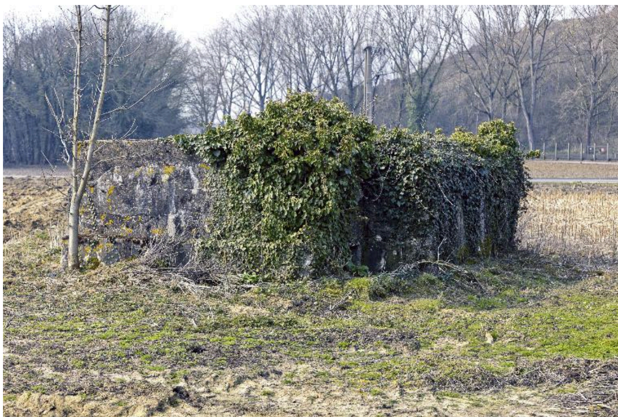
Vue générale vers le sud-ouest
