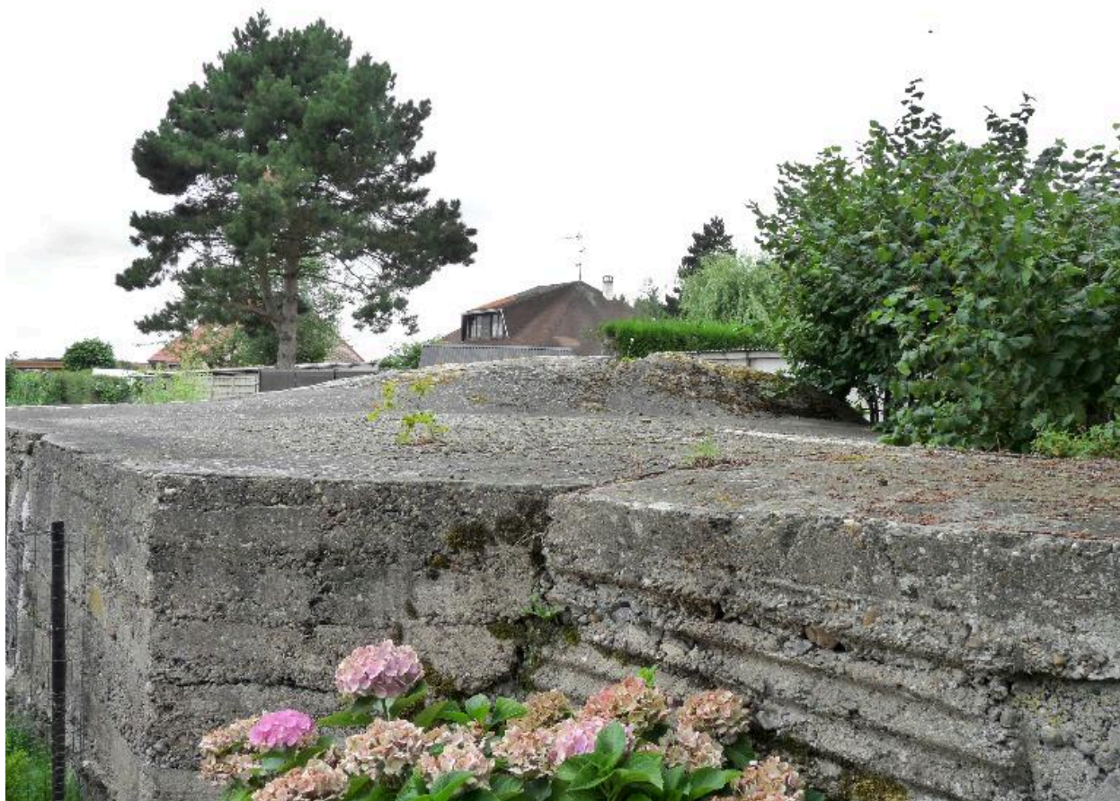
Elévation sud, salle ouest
