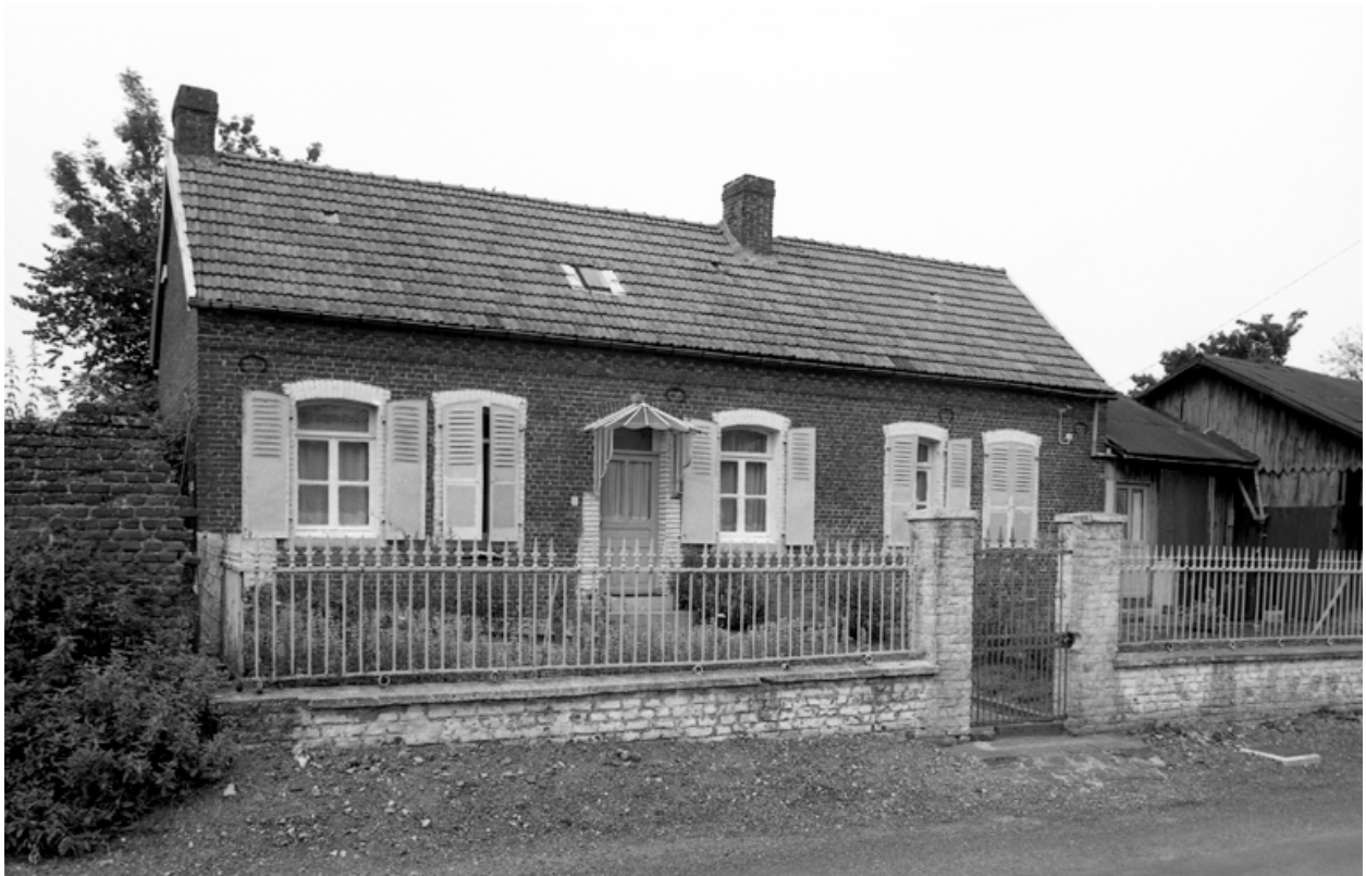
Vue d'ensemble de la façade.
