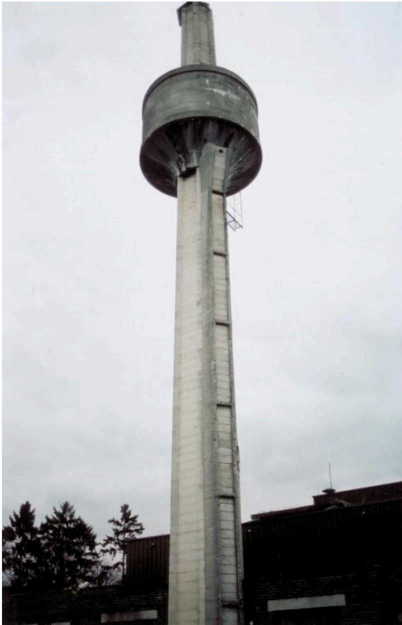
Cheminée de la chaufferie. Château d'eau.
