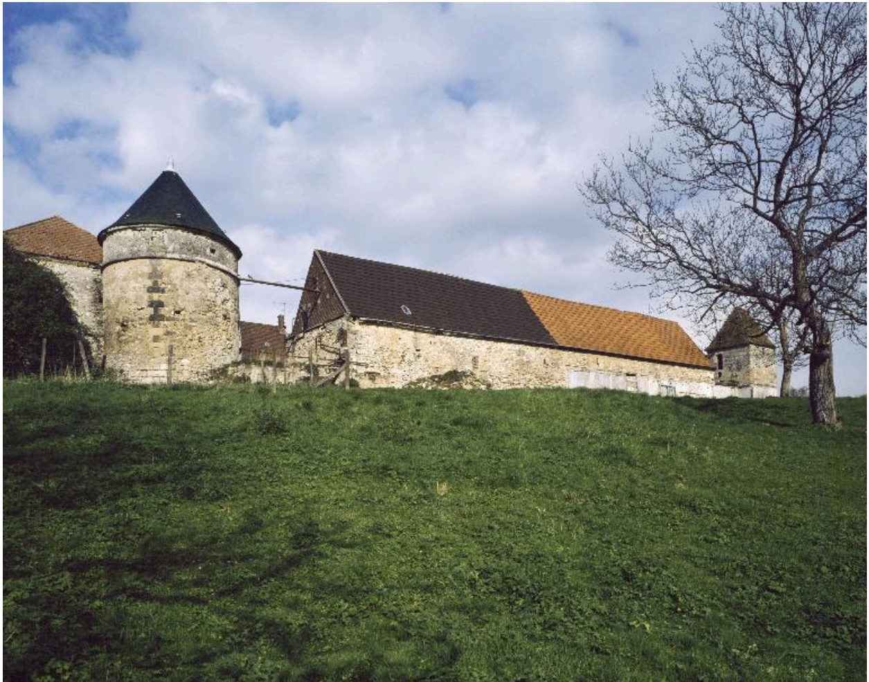
Vue de l'élévation externe de l'aile sud-ouest.
