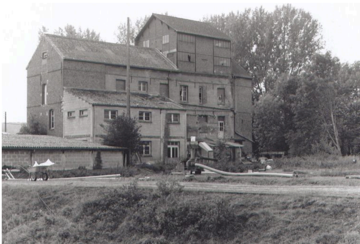
Ensemble postérieur de la minoterie.
