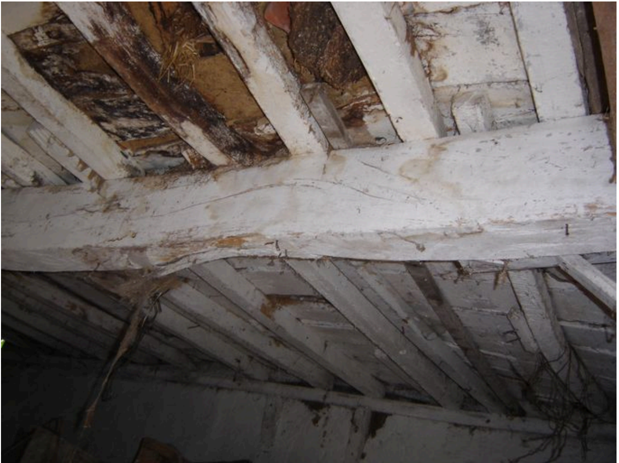
Vue du plafond des écuries.
