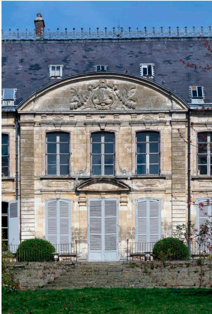
Façade antérieure, partie centrale.
