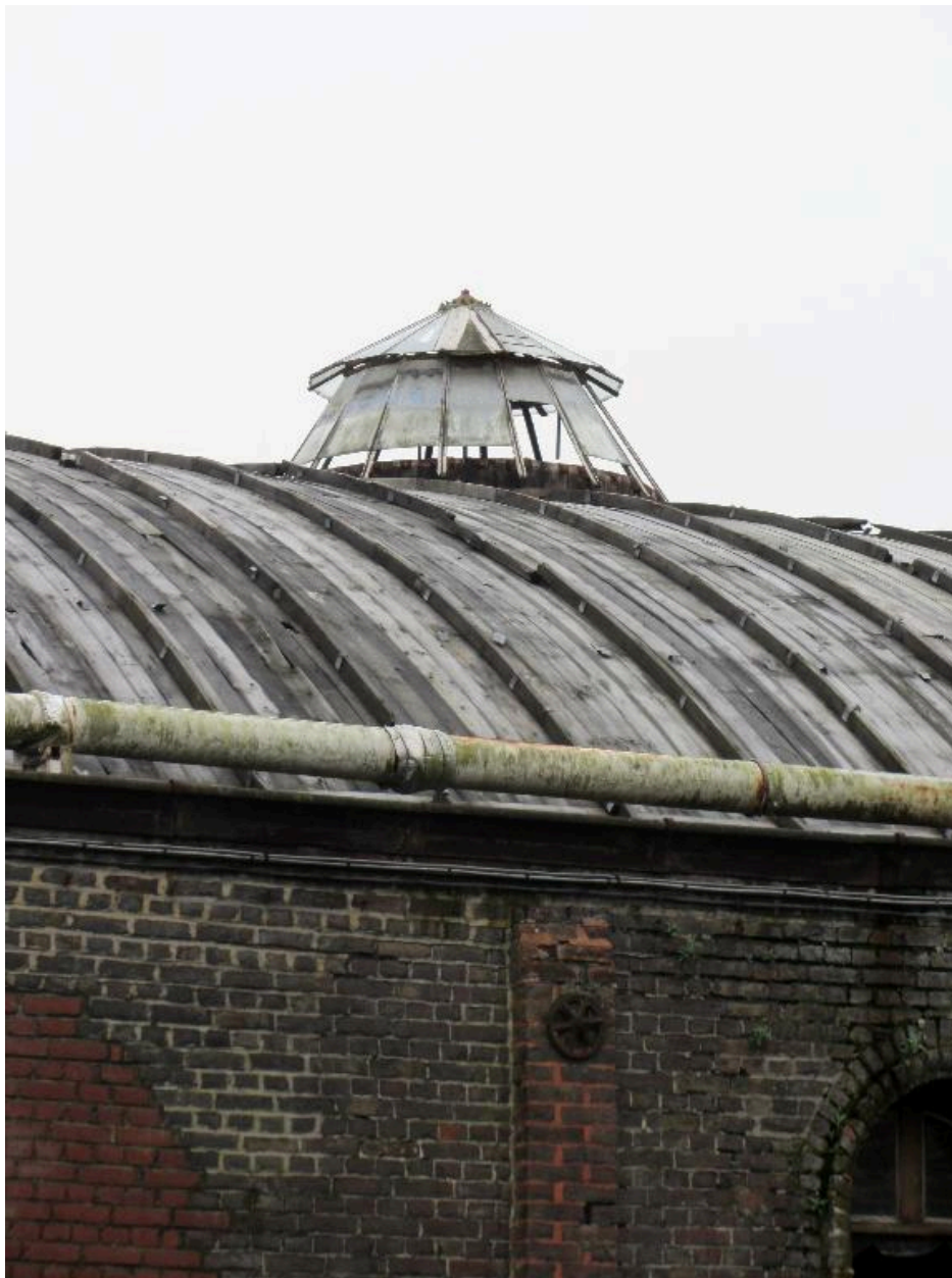
Détail d'un lanterneau en verre au-dessus d'un puits de lumière.
