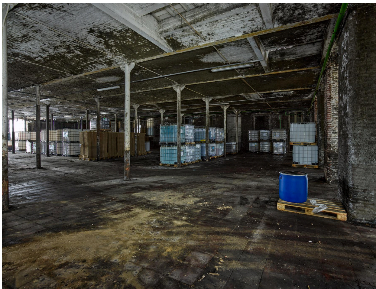
Intérieur du rez-de-chaussée de l'atelier de fabrication (bâtiment K).
