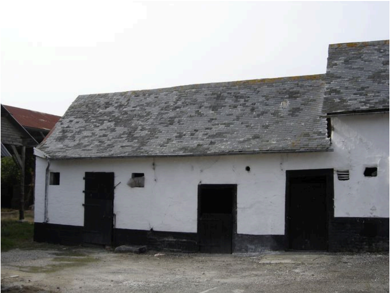
Vue des étables depuis la cour.
