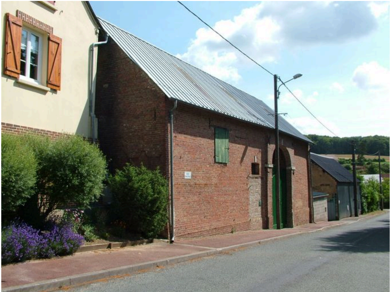
Vue générale depuis la rue, en amont.
