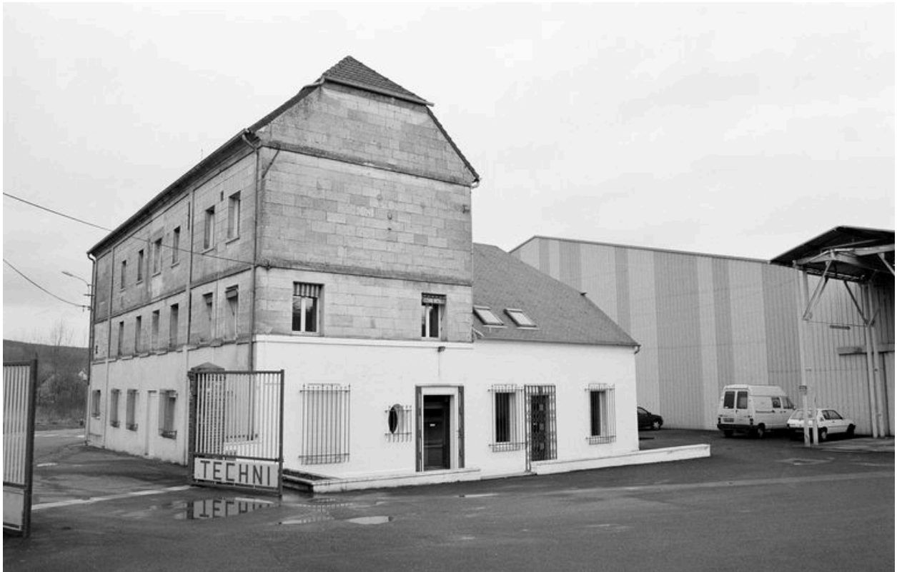
L'ancien moulin à blé, actuellement bureaux.
