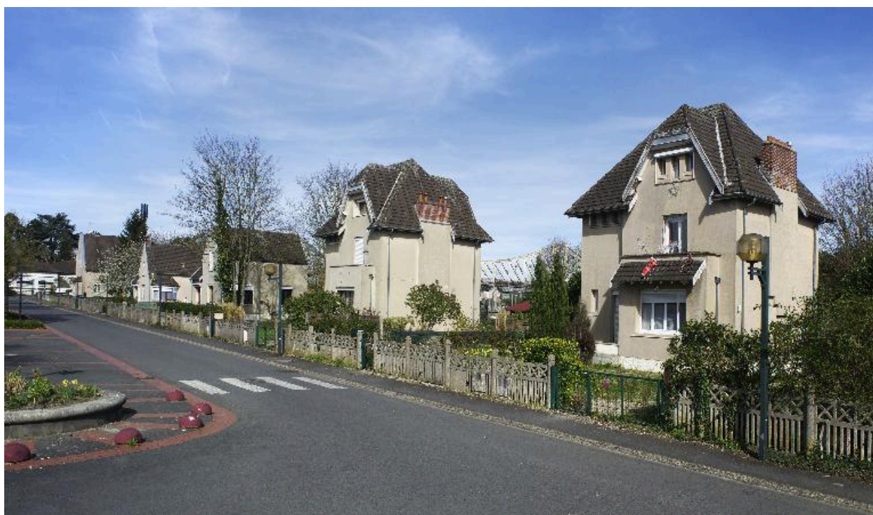
Vue générale des logements.
