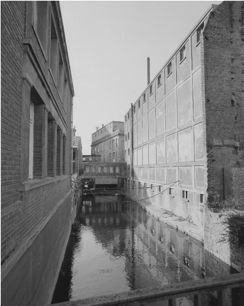
Ateliers de fabrication, vue partielle, flanc sud.
