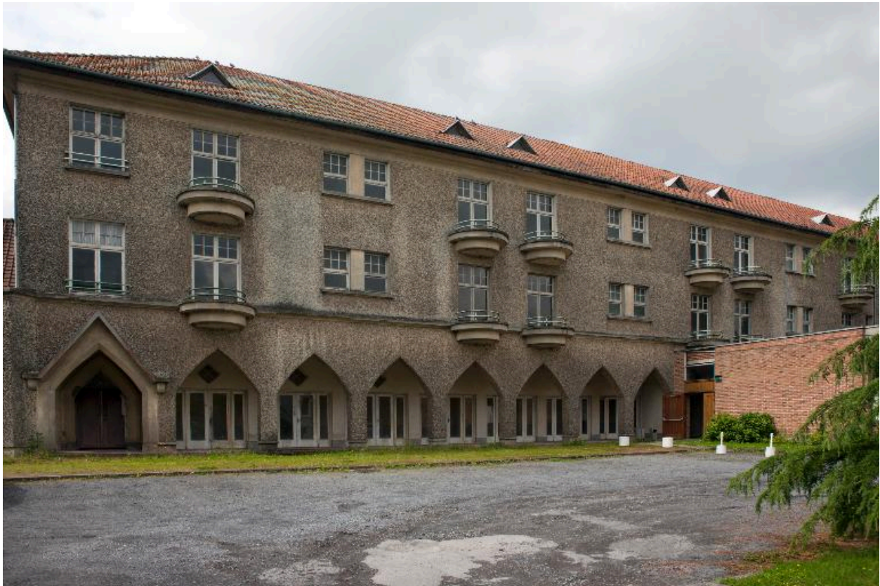
Vue générale de l'ancien hôpital militaire réhabilité dans le projet de Grand Hôtel, élévation postérieure.
