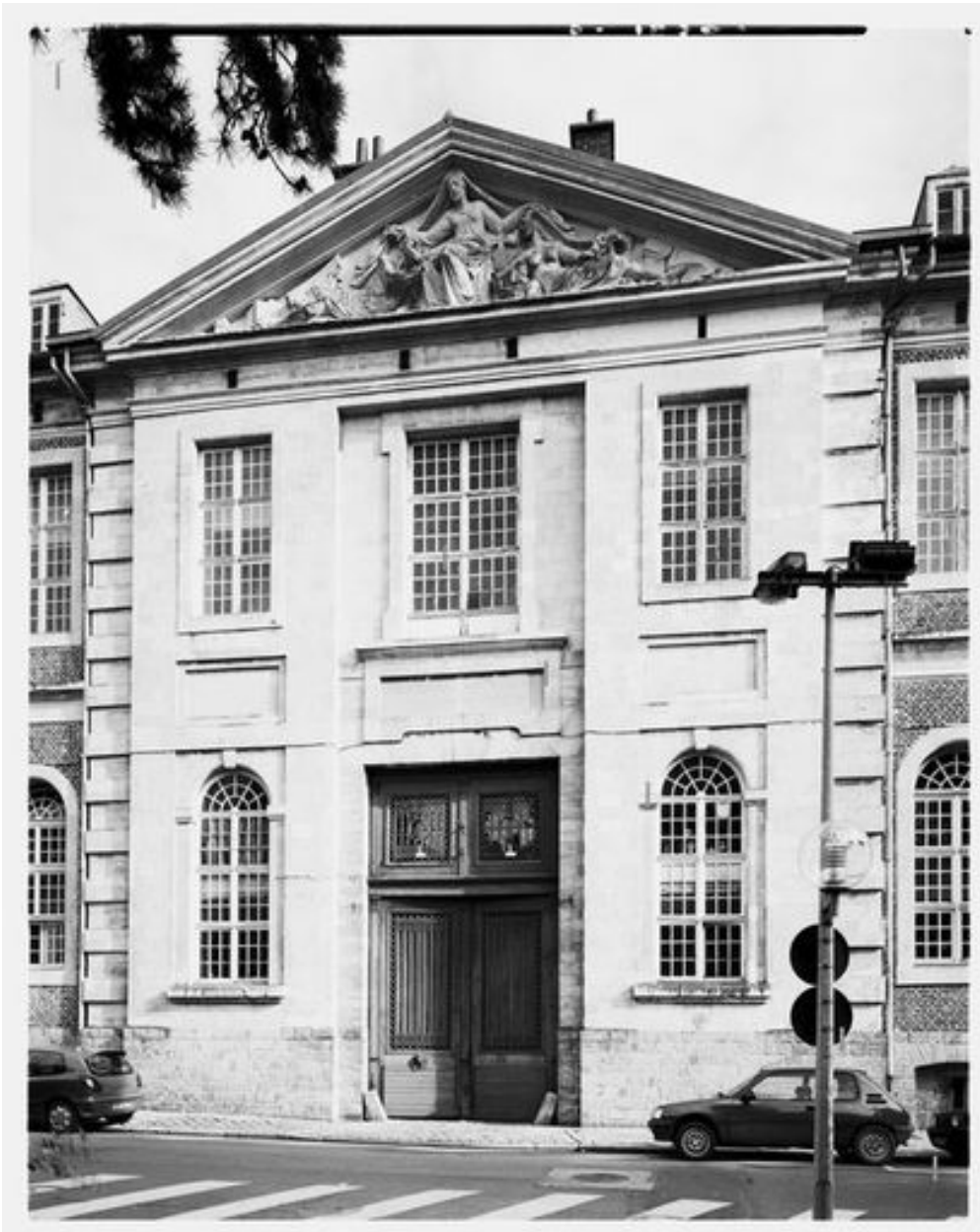
Bâtiment donnant sur la rue de Canteleu, destiné à abriter les infirmeries, élévation antérieure, avant-corps central, vue générale prise de face.
