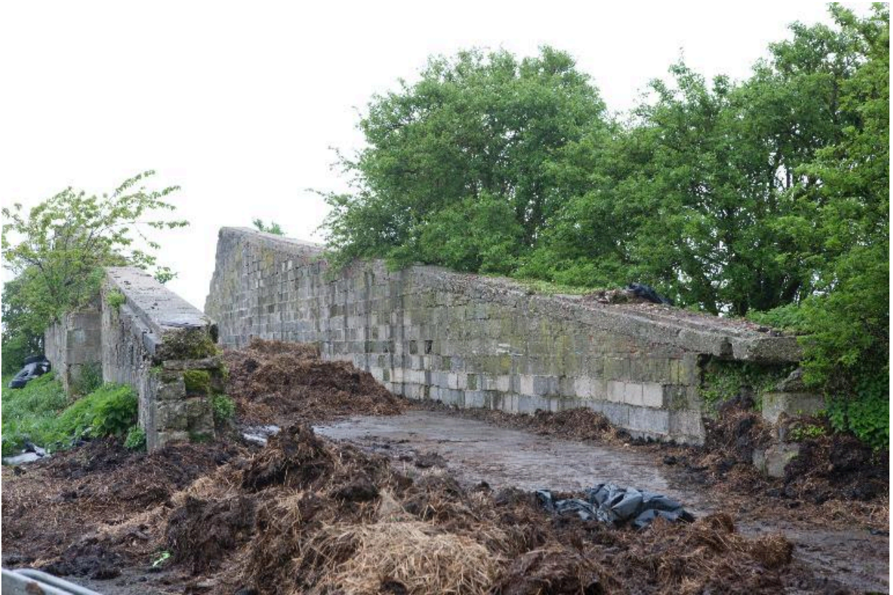
Murs de protection de la rampe de lancement : vue de trois-quarts.
