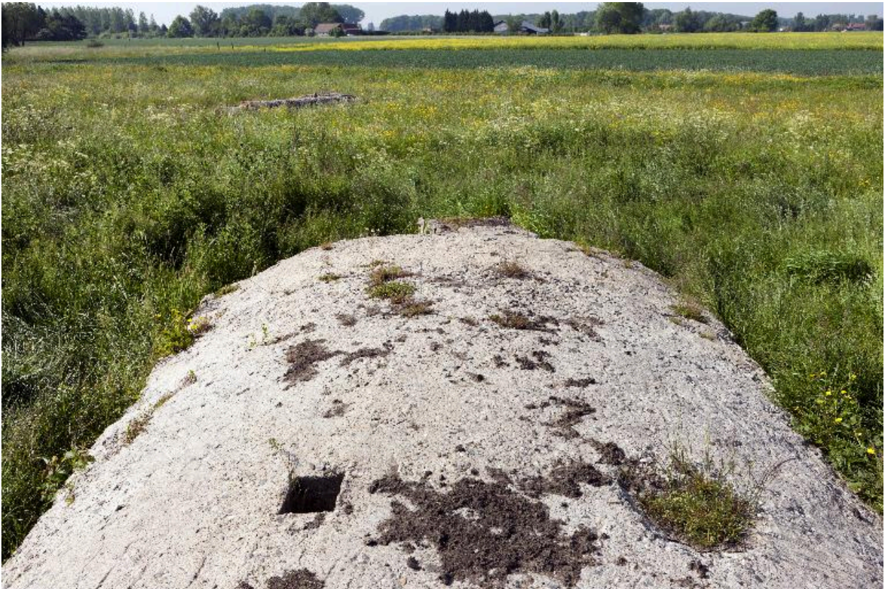
Casemate nord. Cheminée à périscope depuis l'extrados de voûte
