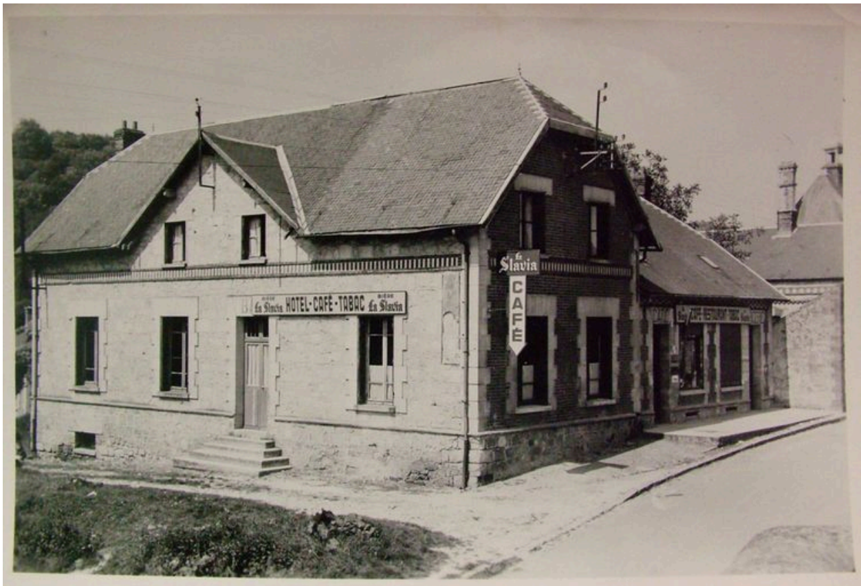
Vue de l'édifice après sa reconstruction (coll. part).
