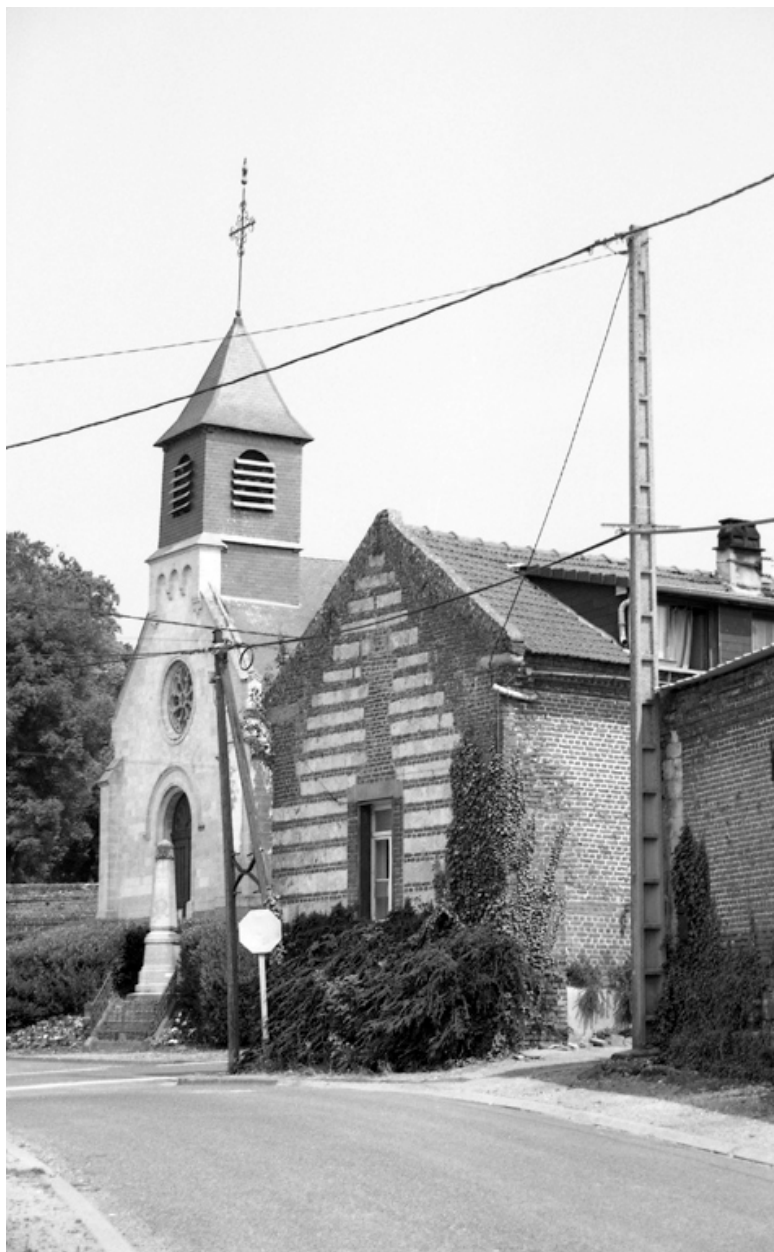
Beaucourt-sur-l'Hallue, ferme, 1 rue du Vieux-Cimetière.
