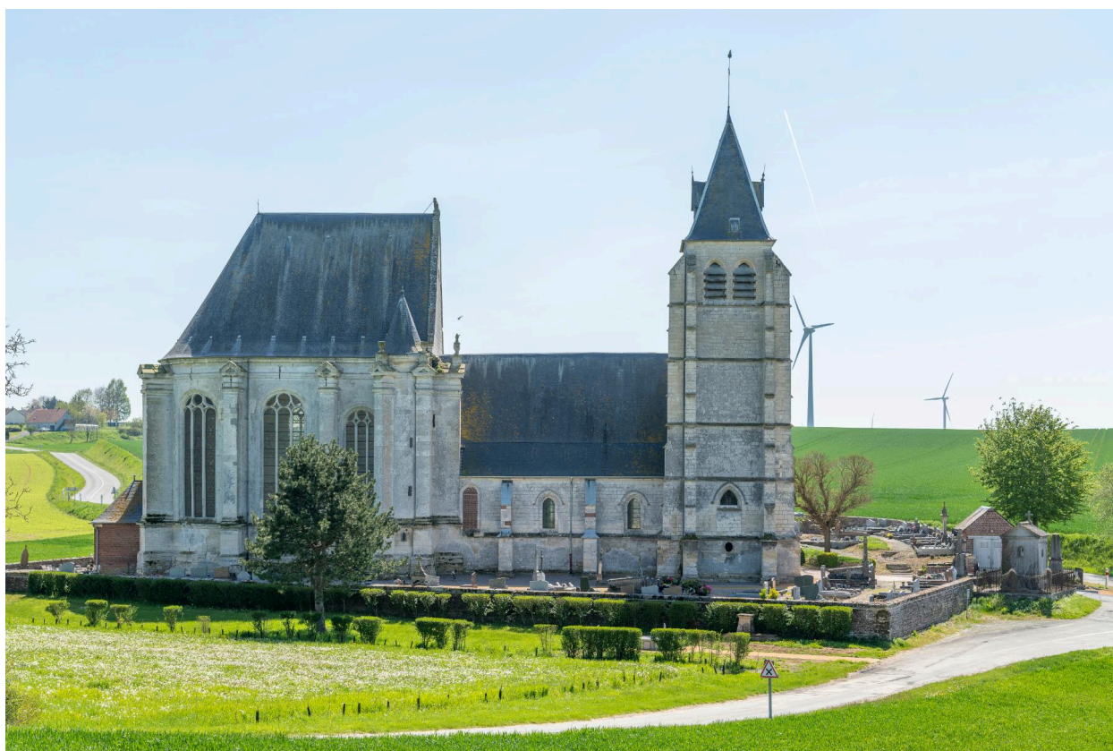
Vue générale de l'élévation nord.
