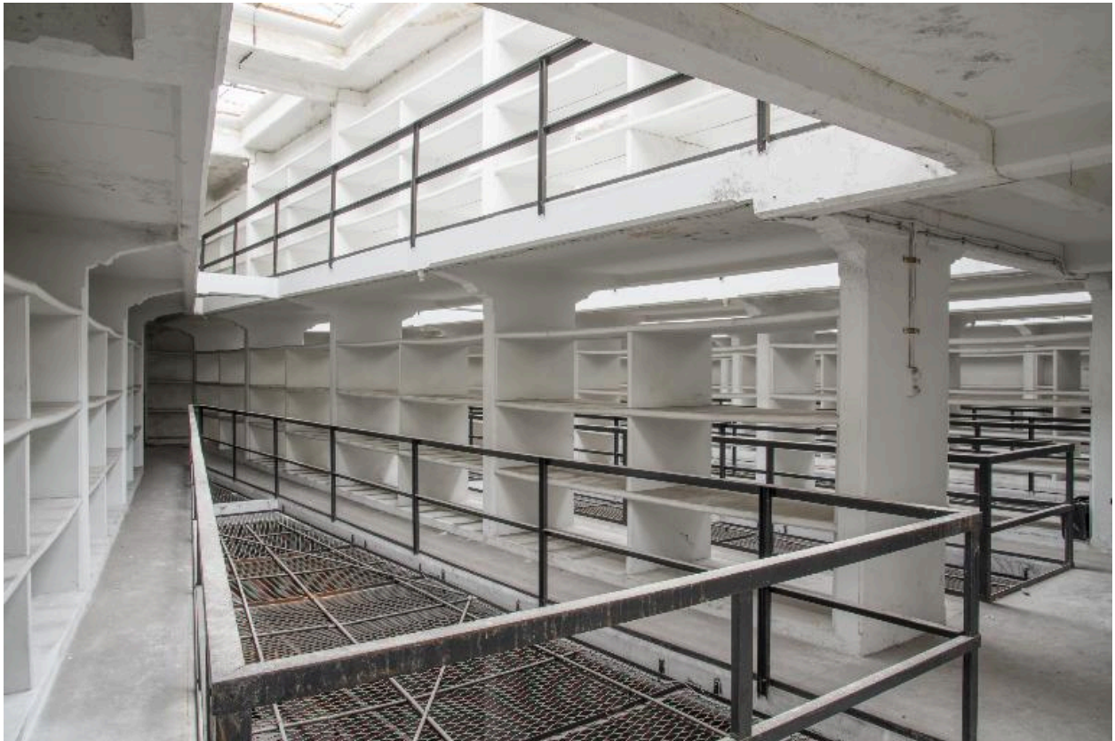
Bâtiment du dépôt, deuxième étage : vue depuis le vaisseau 4 des vaisseau 3, 2 et 1, vers le nord.
