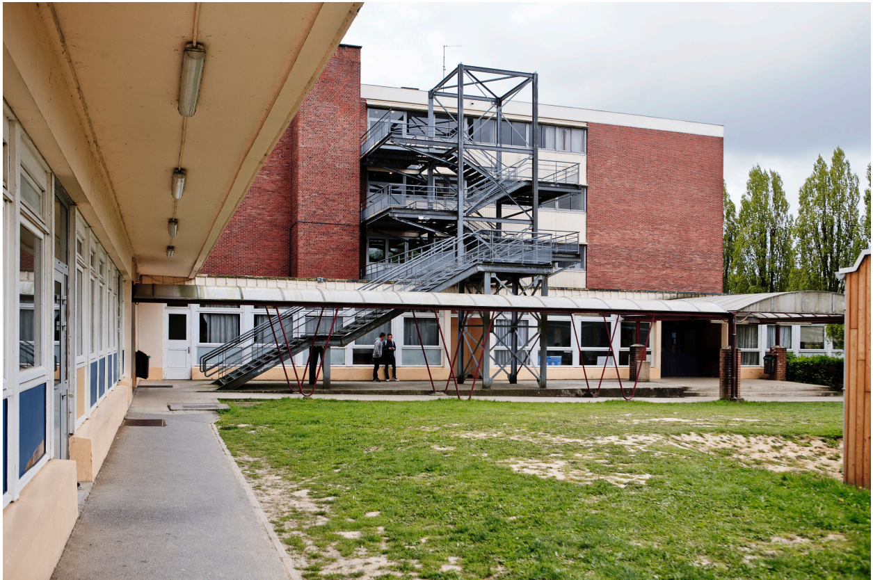
Internats (lycée) : façades nord de l'internat de filles et ouest de l'internat de garçons, 2016.
