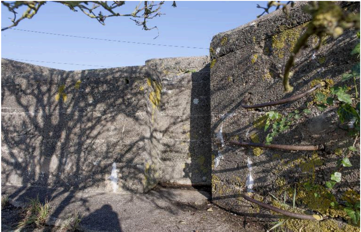
Echélons métalliques donnant accès au couvrement
