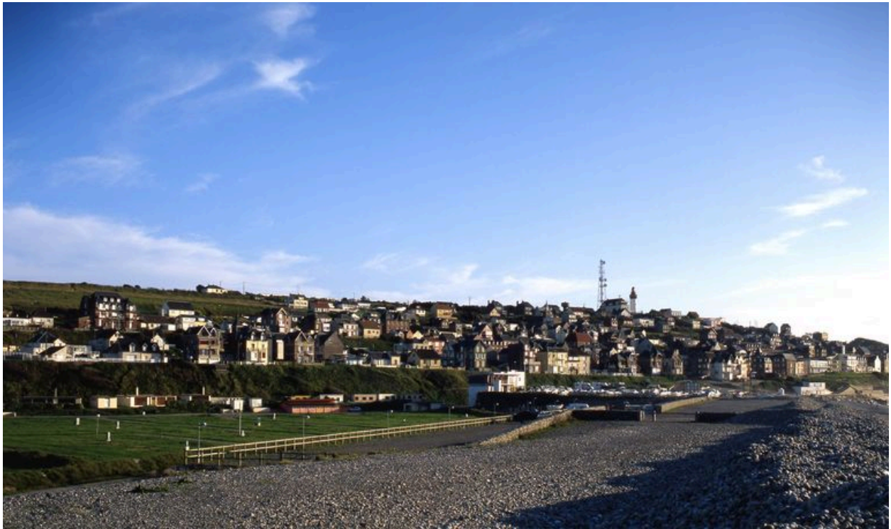
Vue d'ensemble depuis la digue de galets.
