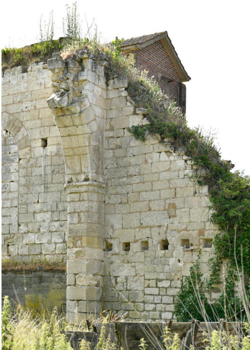
Mur intérieur du pignon sud, côté ouest.
