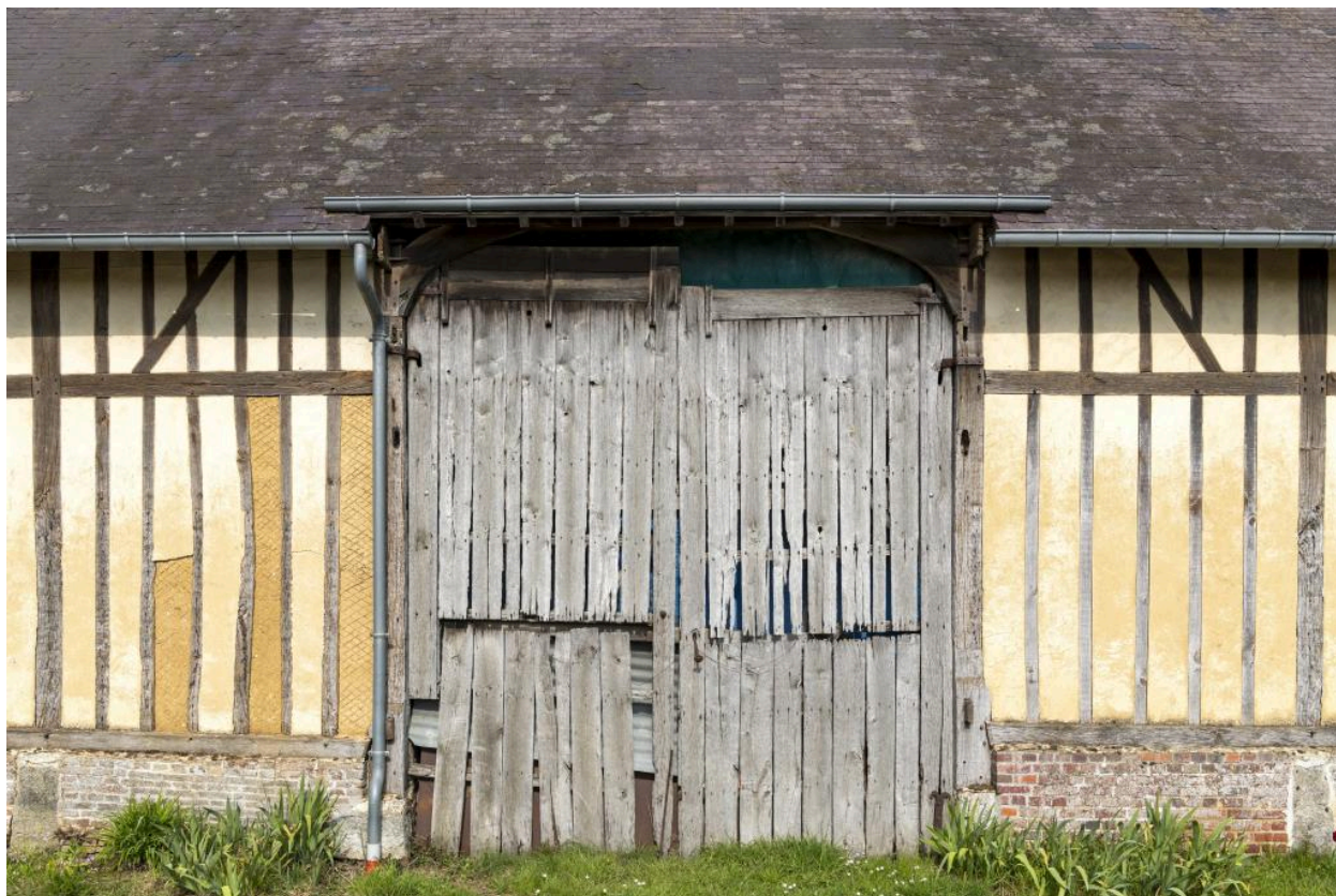
Porte de l'entrée charretière de la grange, n°8 rue Principale, vue depuis l'ouest.
