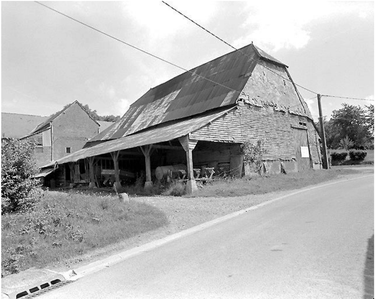
Grange depuis le sud-ouest.
