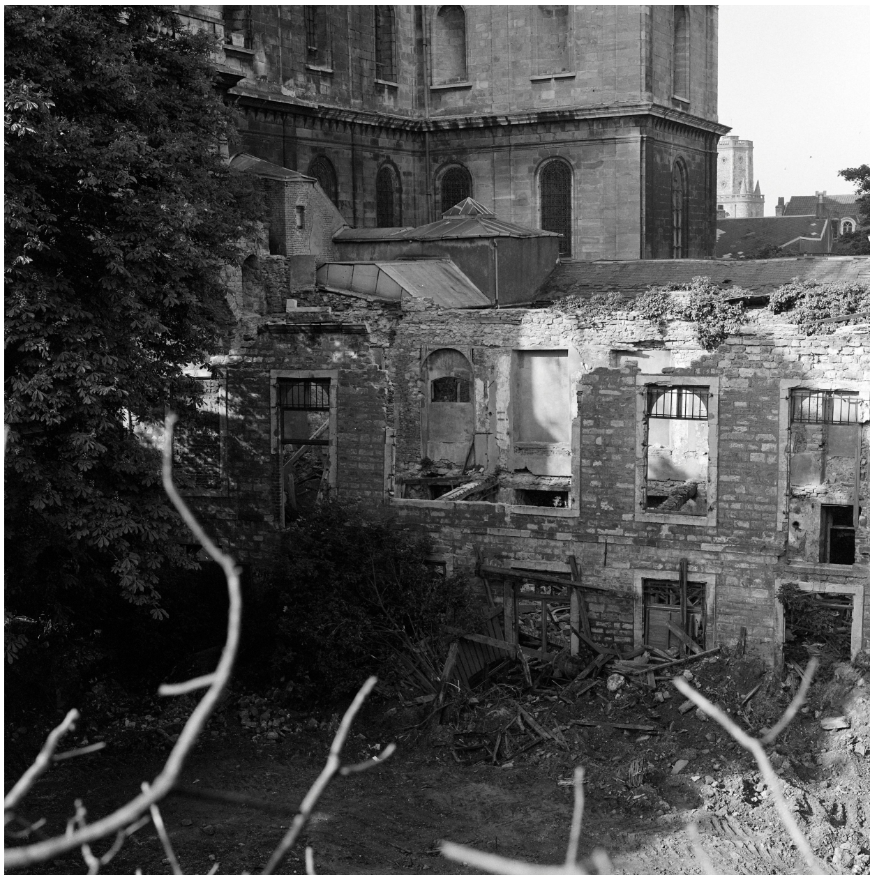
Bâtiment F, façade nord-est sur rempart, vers église.
