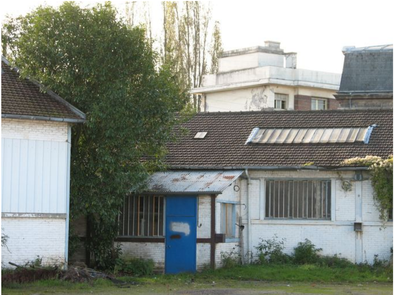
Ancien bâtiment du réfectoire.
