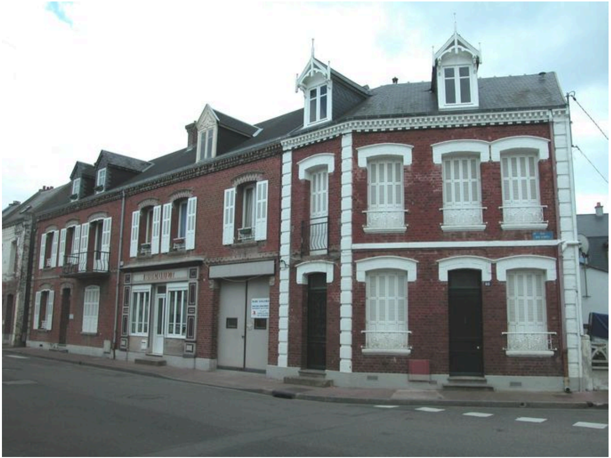
Vue d'ensemble des trois logements accolés.
