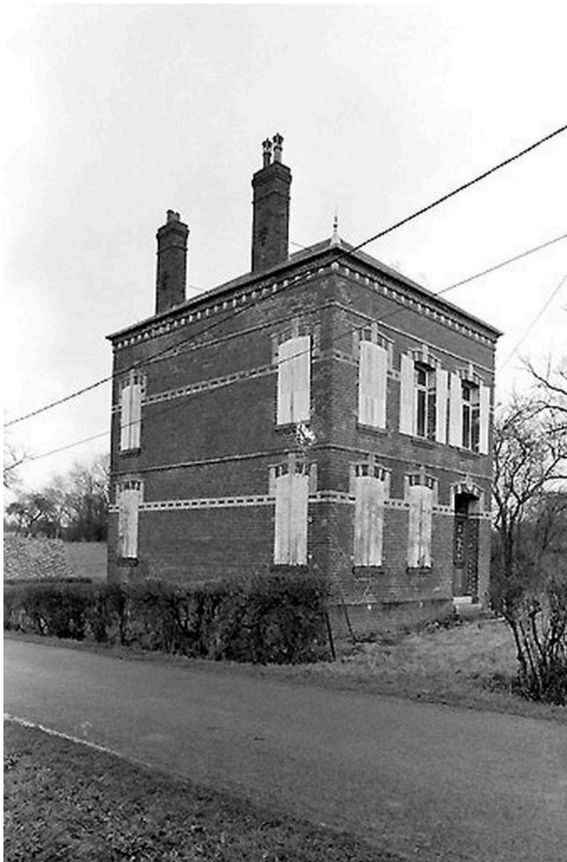
Maison non étudiée, 1 route départementale 744.
