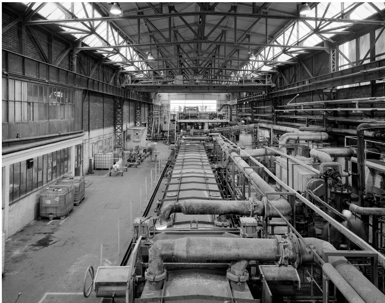
Vue générale du bassin de traitement.
