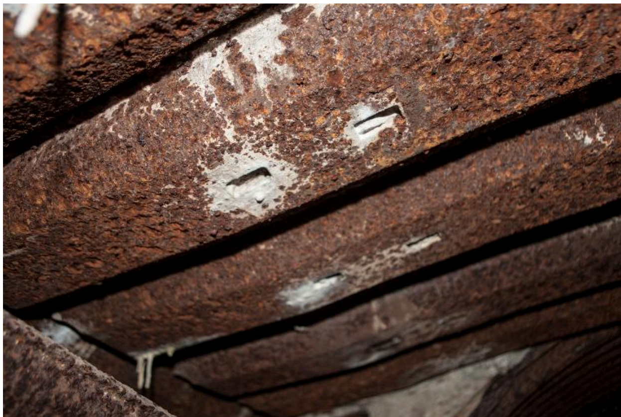
Palplanche servant de coffrage
