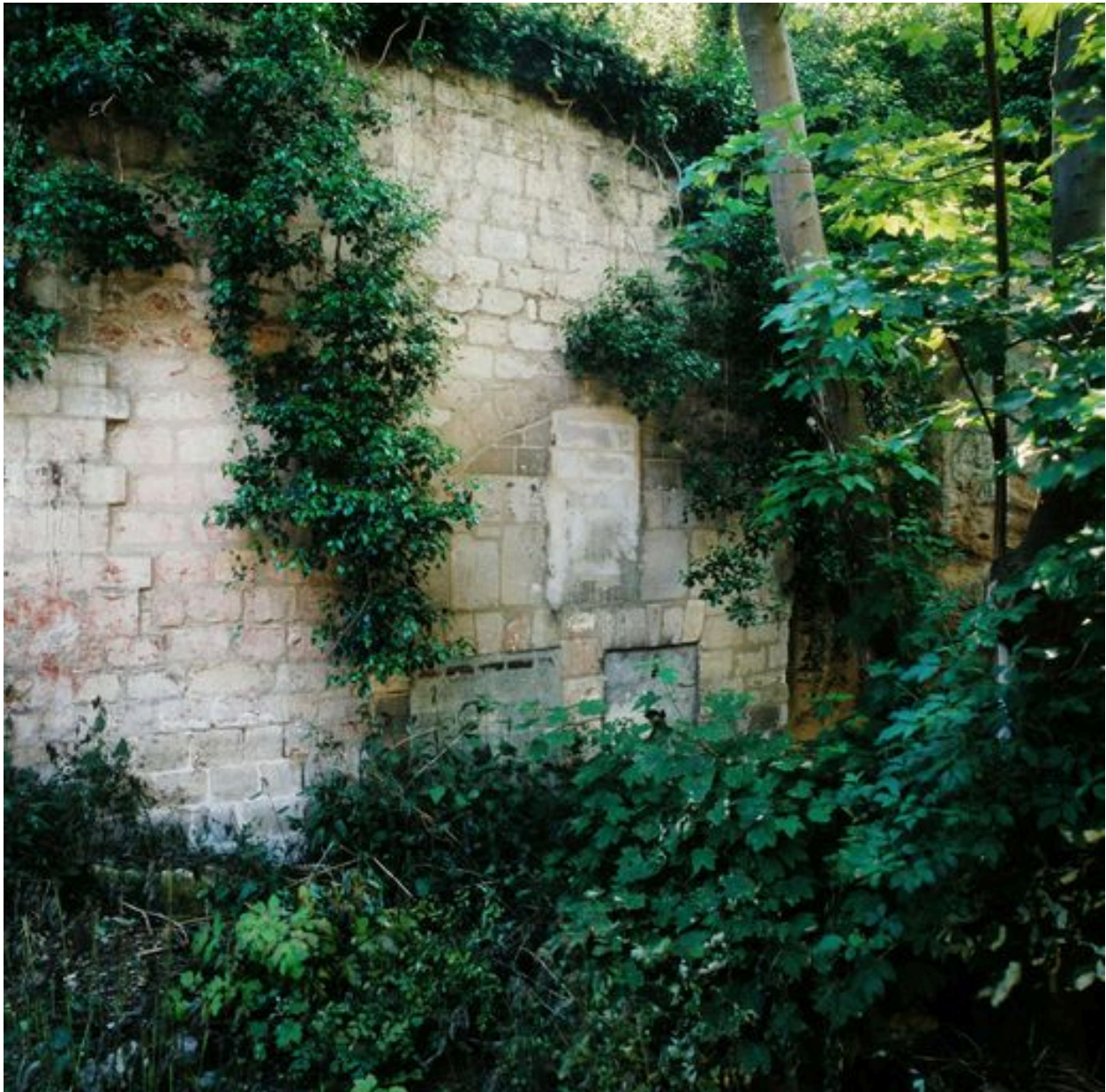
Ancienne habitation troglodytique (Creil).
