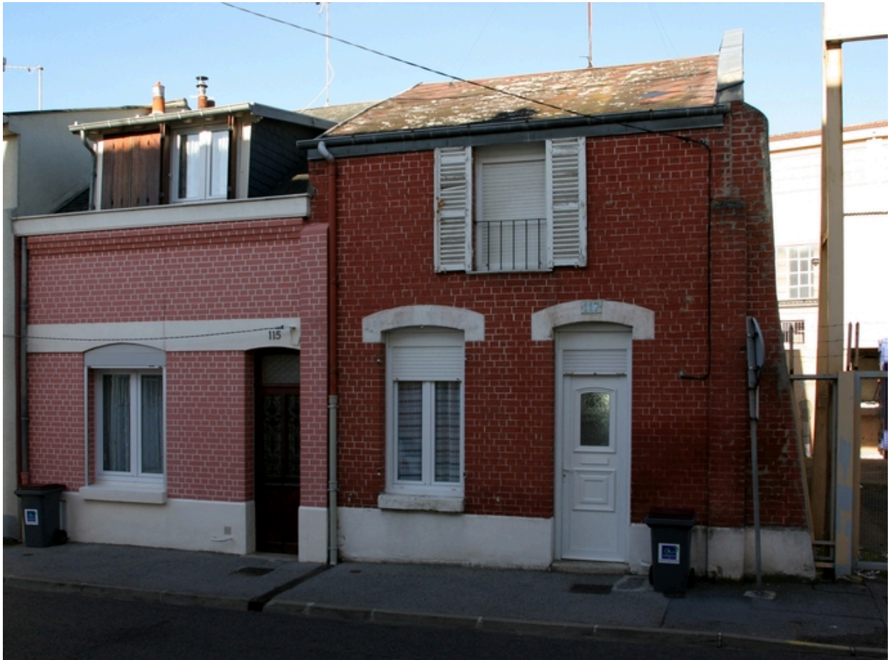
Façade antérieure de deux logements ouvriers.
