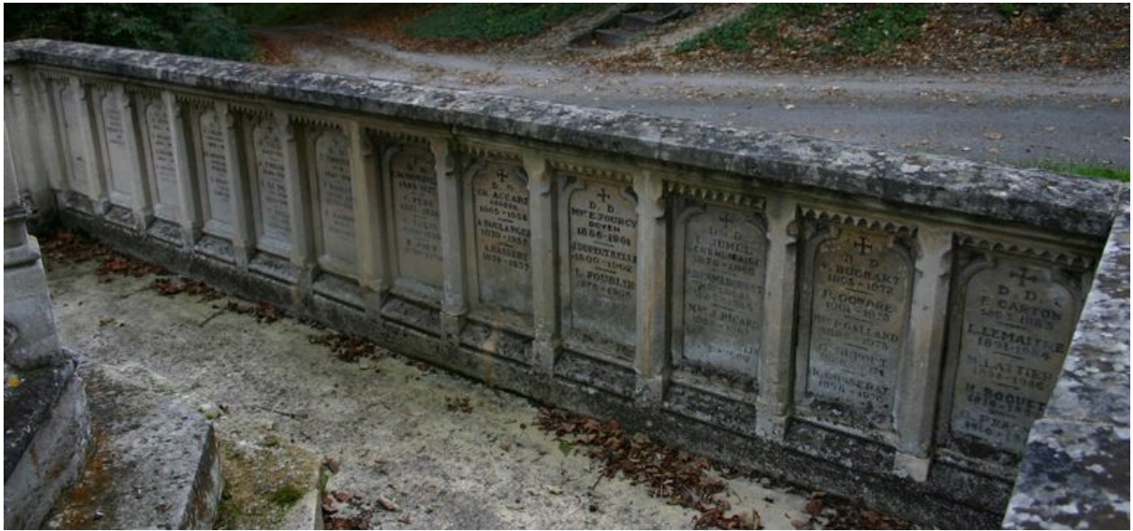
Détail du mur-pâlis intérieur.
