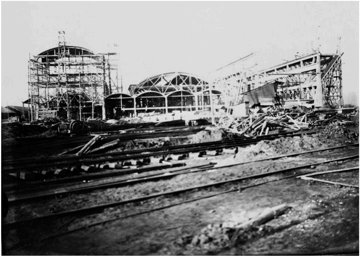
Vue générale des ateliers de fabrication, vers 1925 (AP).
