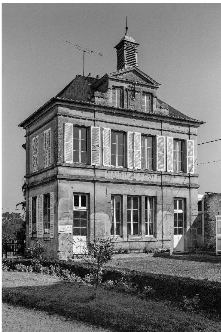
Vue générale, depuis le sud.
