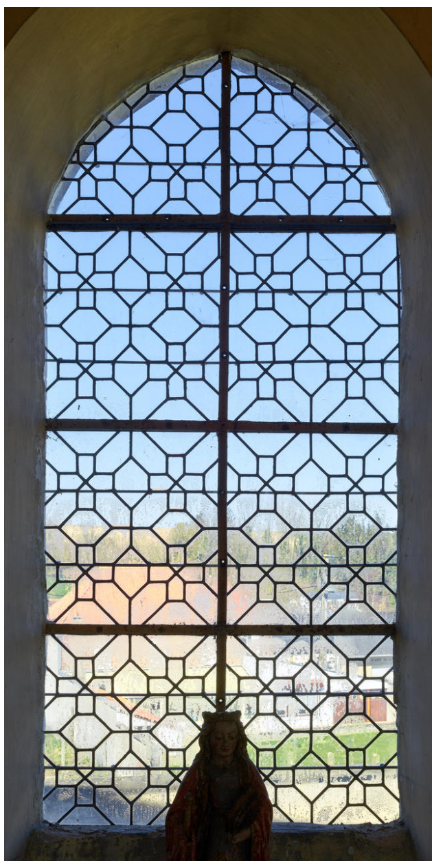
Verrière (baie 9) : verrière à borne.
