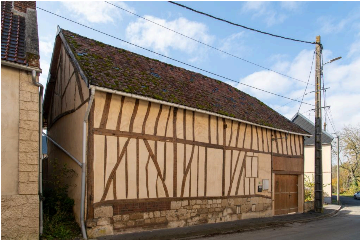
Ancienne grange sur rue en pans de bois et torchis avec solin en pierre, n°1 rue du Pont Cocu, vue depuis le nord-est.
