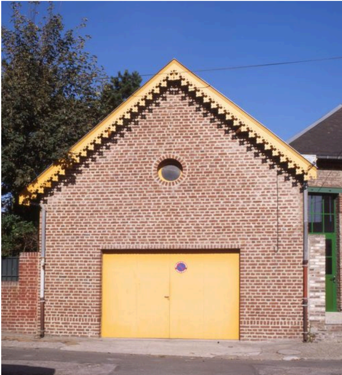
Le garage isolé.
