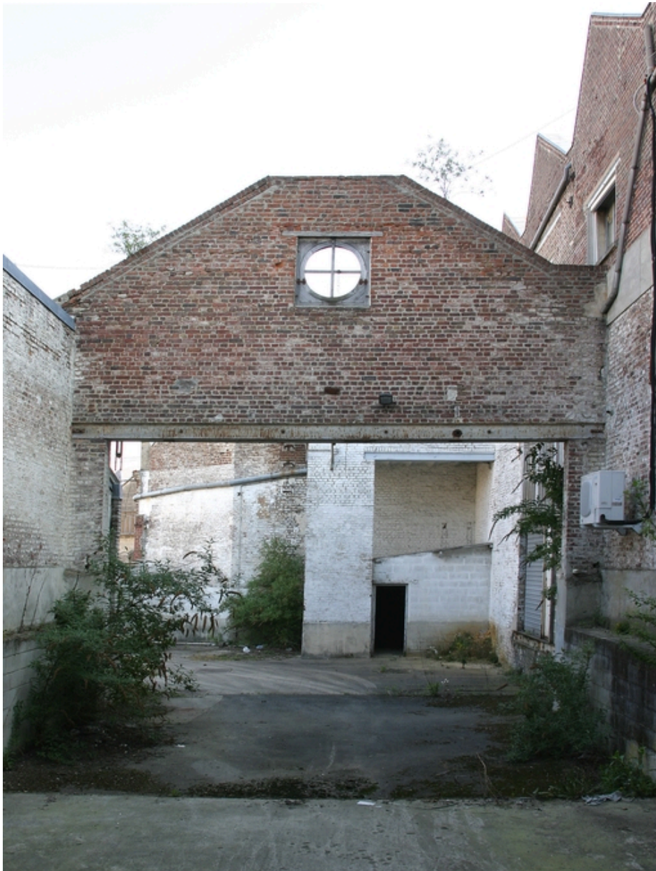
Pignon de l'ancienne salle des machines.
