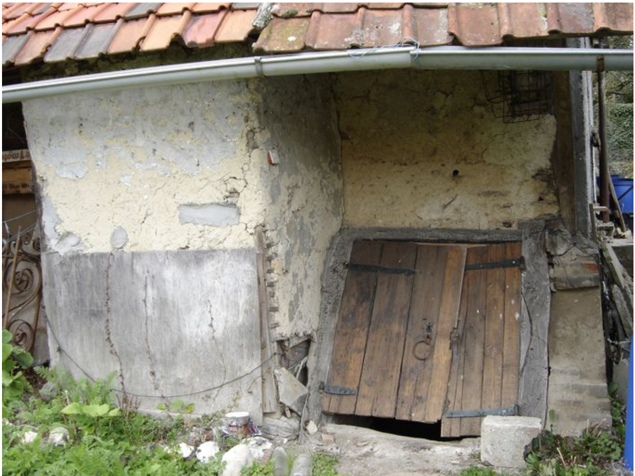
Détail de l'accès à la cave située au nord de la cour.
