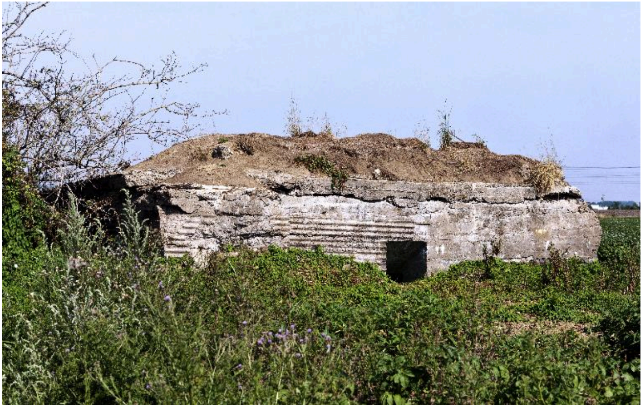
Vue de trois-quarts vers nord
