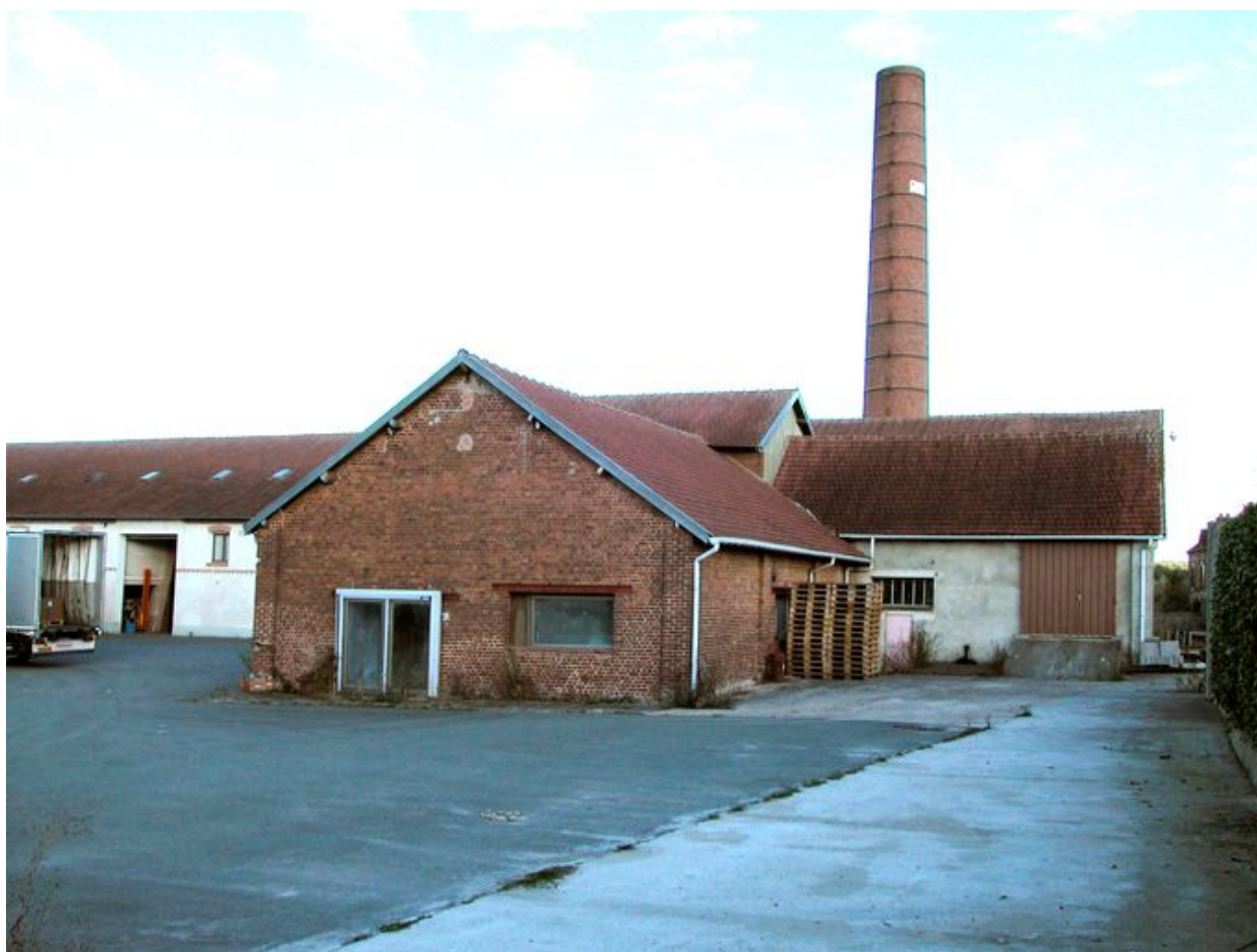
Vue d'ensemble des bâtiments sur cour.
