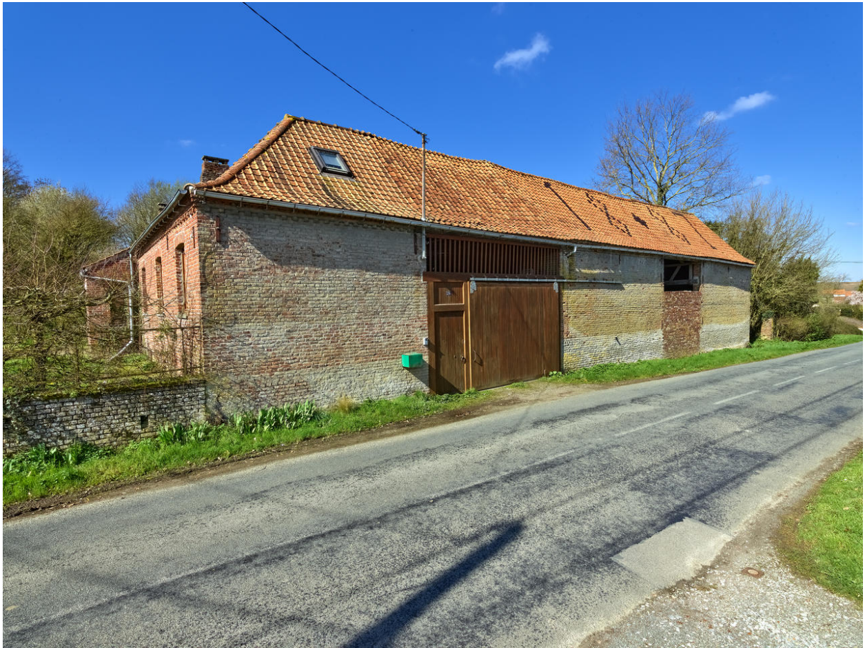
Ferme en brique et tuile, datée de 1887, rue Haute.
