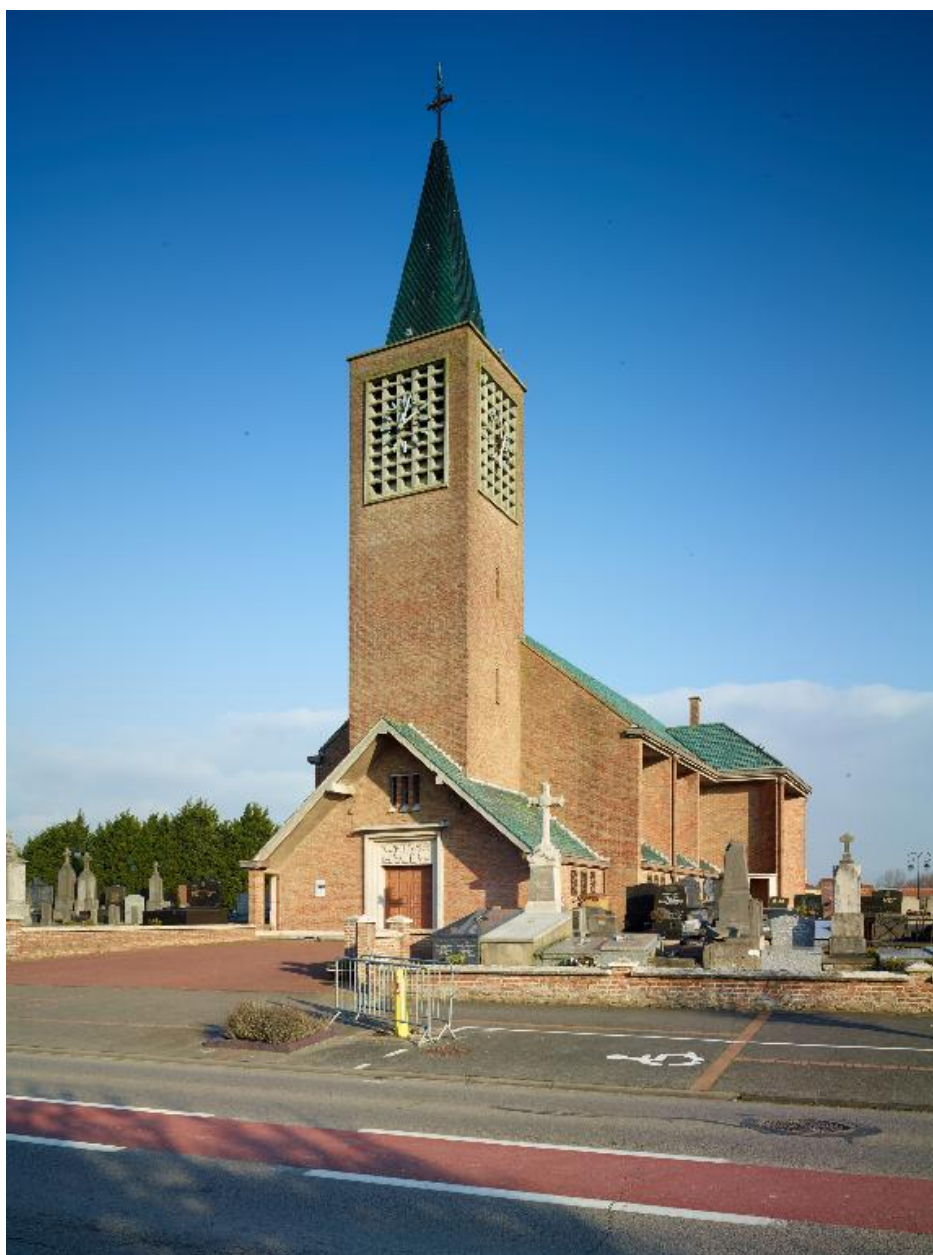
Elévation antérieure de trois quart droit
